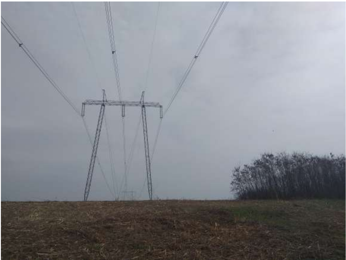
Távvezeték oszlop a tervezési területen, előtte a lezúzott rézsű
